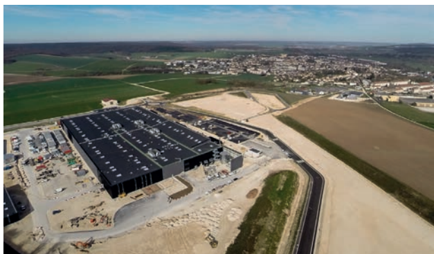
Commercy : vue aérienne du site en travaux.
